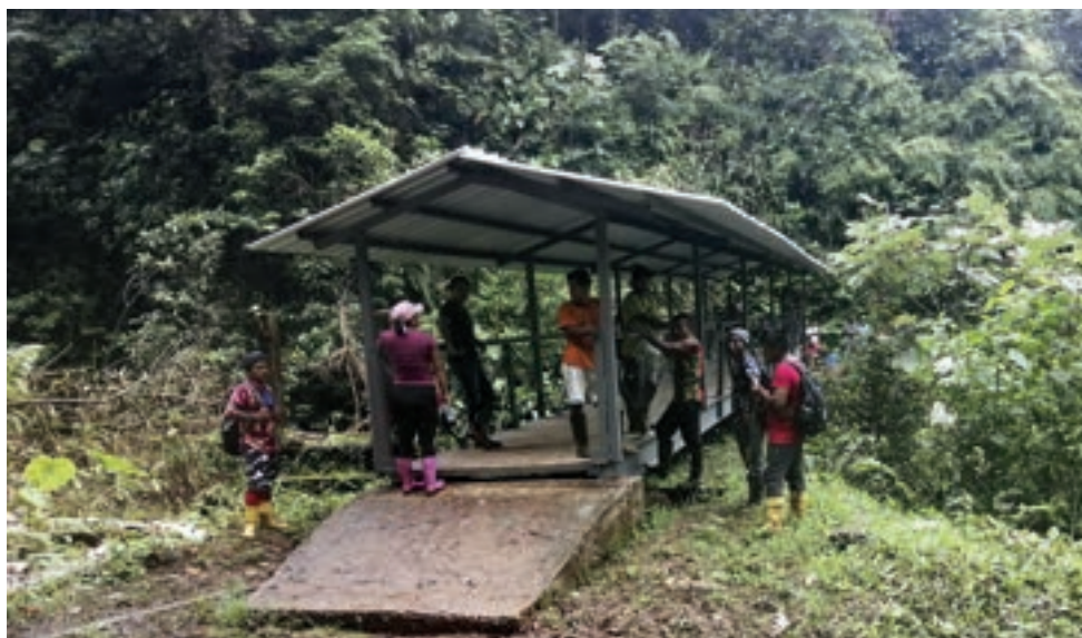
...riparazione del ponte sul Rio Mira e copertura con un tetto prima e dopo.
