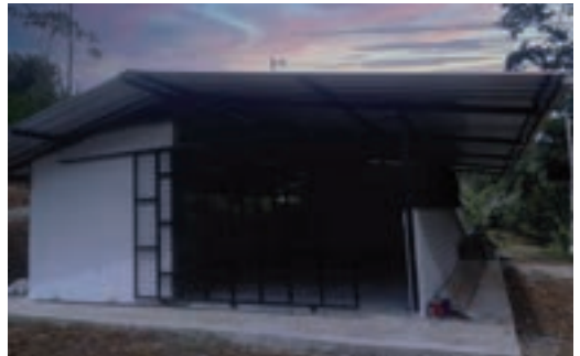
Capannone per piladora e altro.
