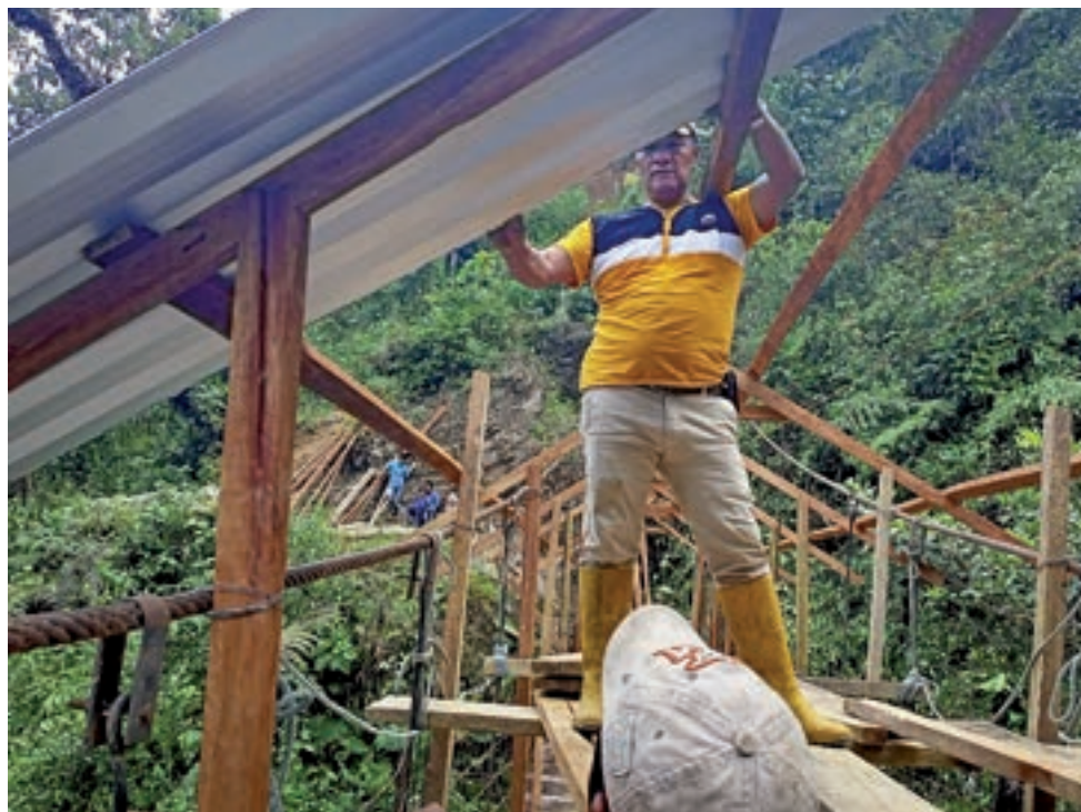
...copertura con un tetto del ponte sulla Quebrada Amarilla.
