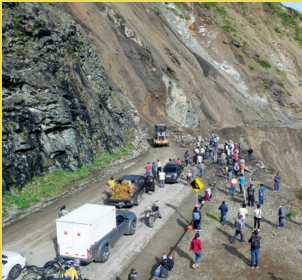
Foto 15 - Blocco stradale causato dall'ennesima frana
