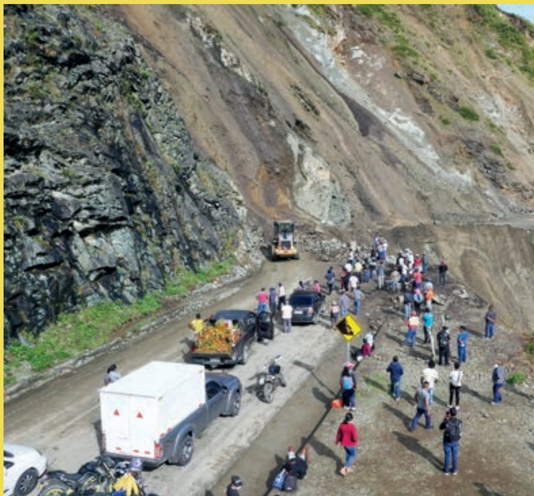
Foto 15 - Blocco stradale causato dall'ennesima frana
