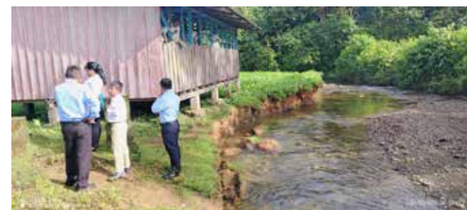
Fornitura di materiale per permettere lo spostamento di un'aula scolastica a San Marcos che rischiava di essere portata via dalla piena di un torrente
