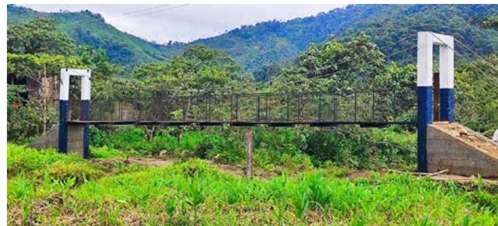
San Marco quebrada nuovo ponte
