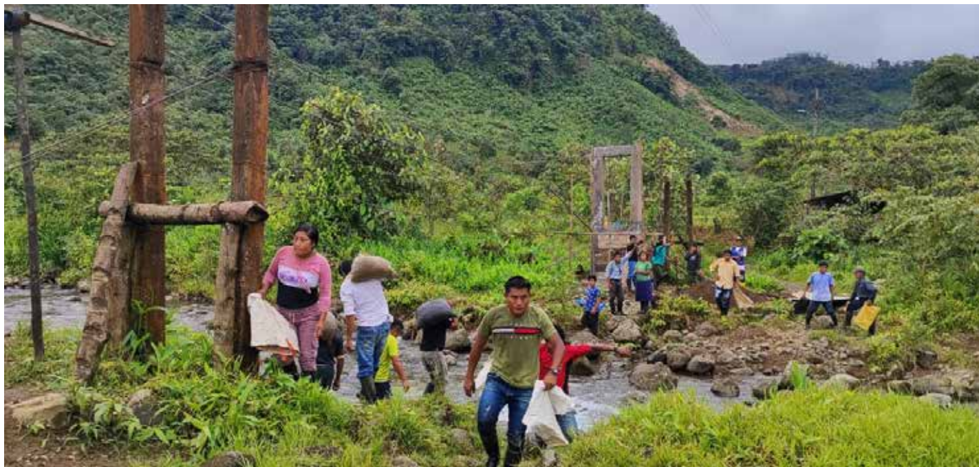
San Marcos minga per la costruzione del ponte nuovo
